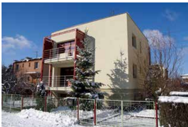
Dom po termomodernizacji
