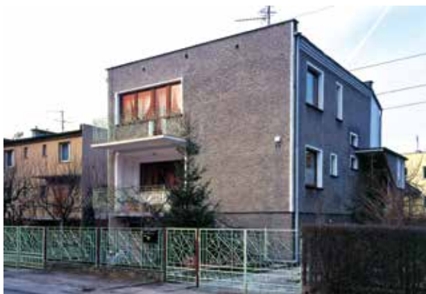
Dom przed termomodernizacją
