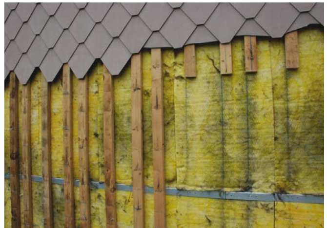
Przykład udokumentowanej pobranej próbki: fasada wentylowana
