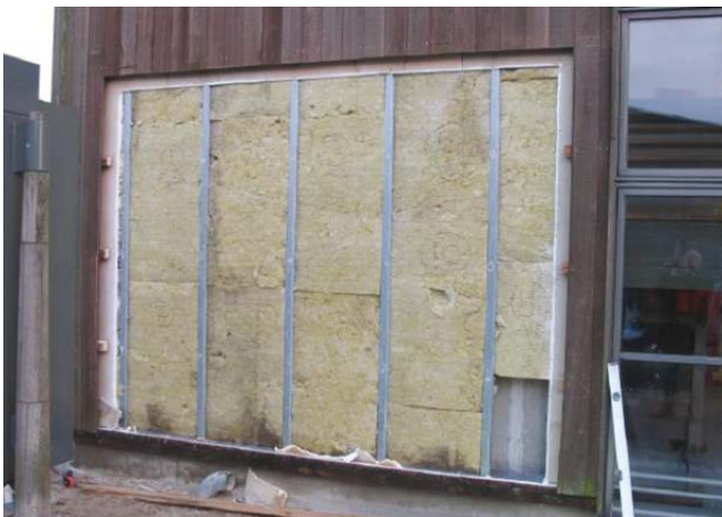
Przykład udokumentowanej pobranej próbki: element ściany
