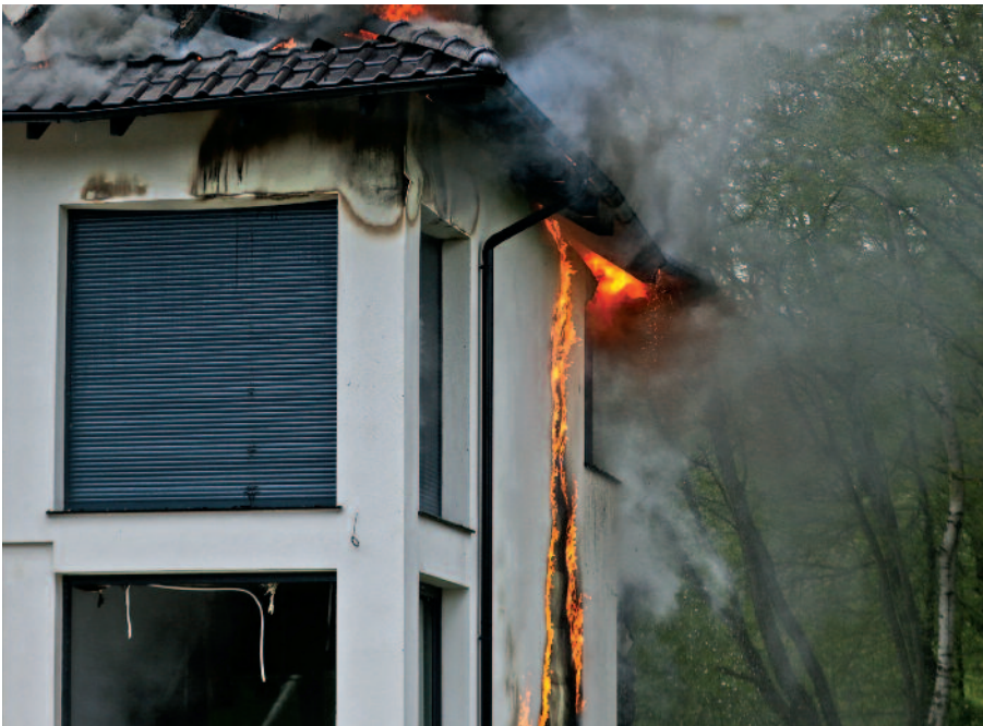
2. Pożar dachu w nowym domu jednorodzinym
