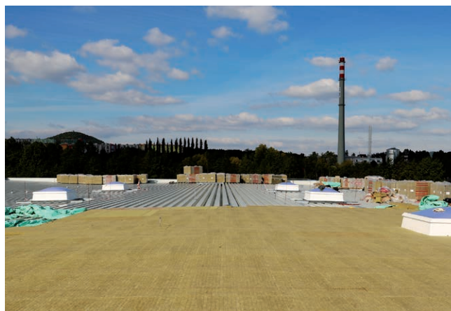
FOT. 4. Do izolacji akustycznej dachów płaskich z blach trapezowych pełnych i perforowanych stosuje się płyty z wełny mineralnej o różnych gęstościach;
