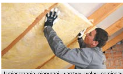
Umieszczanie pierwszej warstwy wełny pomiędzy krokiewiami
