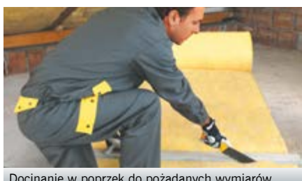
Docinanie w poprzek do pożądanych wymiarów
