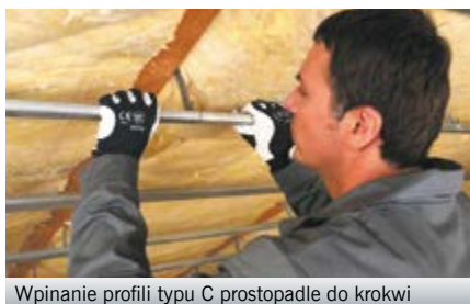
Wpianie profili typu C prostopadle do krokwi
