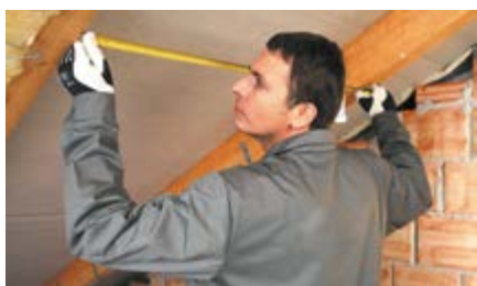
Pomiar rozstawu pomiędzy krokiewiami
