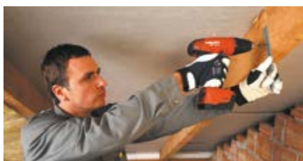
Montaż stalowego stelaża
