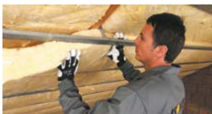
Montaż drugiej warstwy prostopadle do poprzedniej
