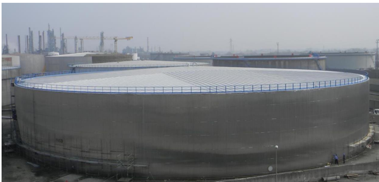
PO: Dach zbiornika nowo zabezpieczony izolacją o grubości 30 mm i długotrwałą ochroną antykorozyjną
