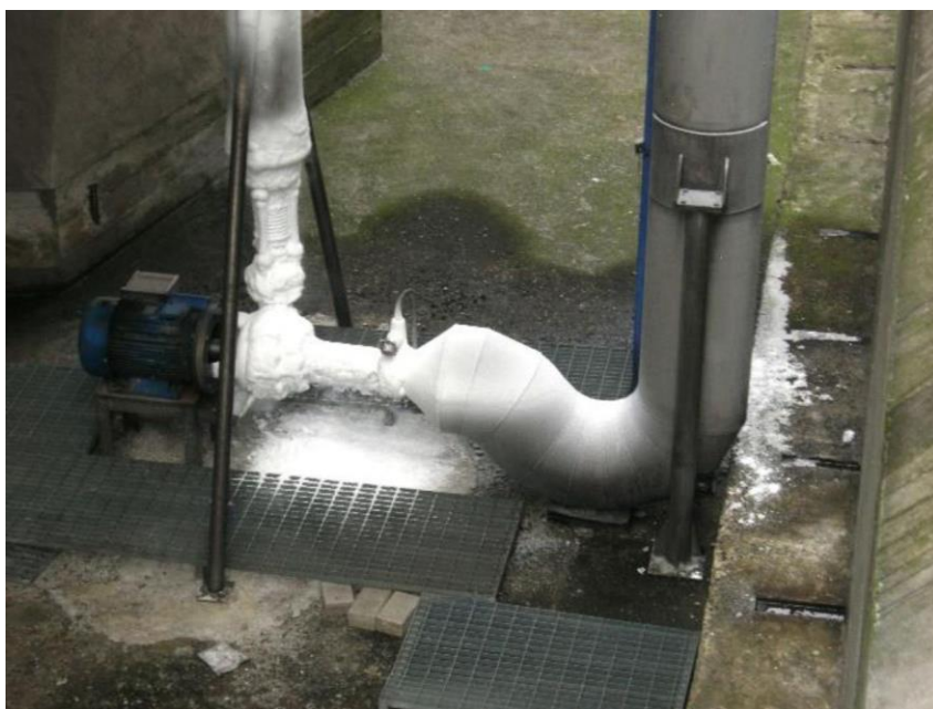
Pompa całkowicie pokryta lodem przestaje pracować
